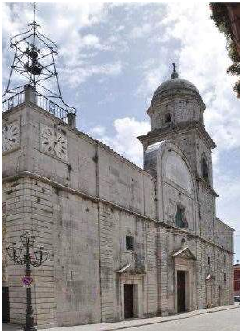
Figura 35 Facciata principale della chiesa
