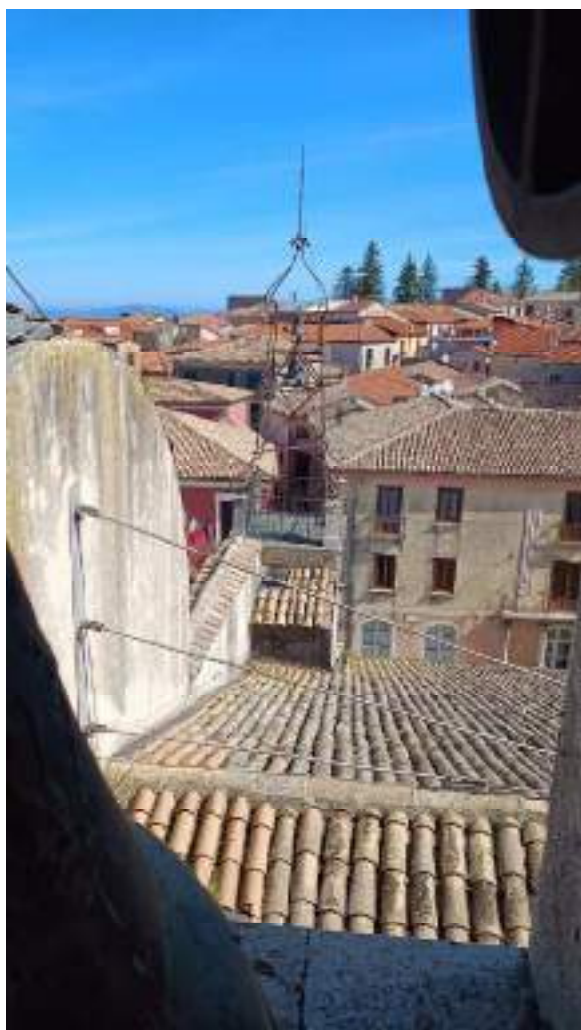
Figura 38 sullo sfondo della foto è visibile la struttura metallica di sostegno della campana
