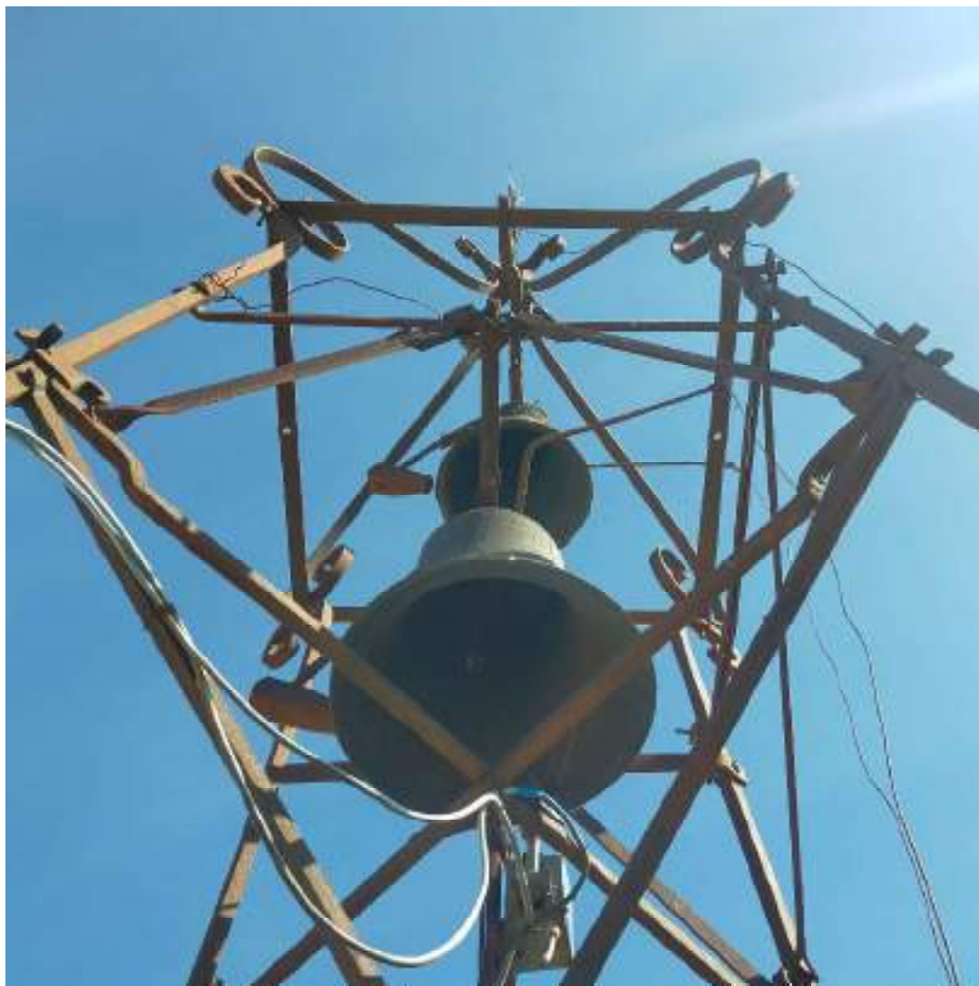
Figura 37 Struttura in metallo a sostegno della campana
