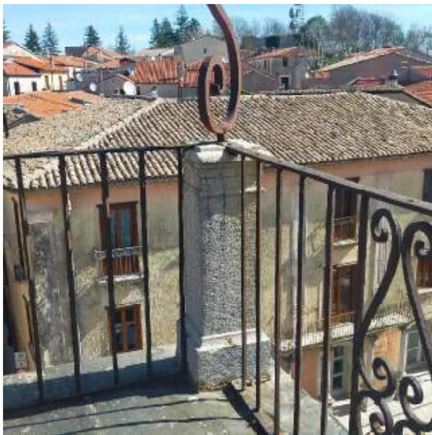
Figura 39 Balaustra in metallo a protezione del terrazzino su ci insite la struttura metallica della campana
