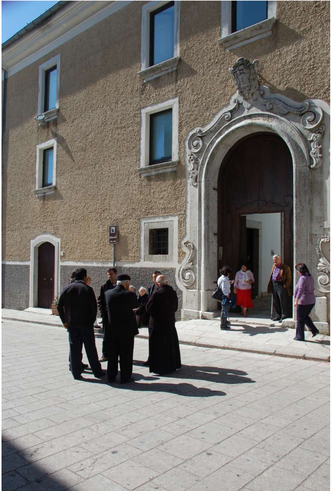
Palazzo Vescovile di Nusco (Av), ingresso da Piazza Vescovado in copertina, facciata del chiostro interno
