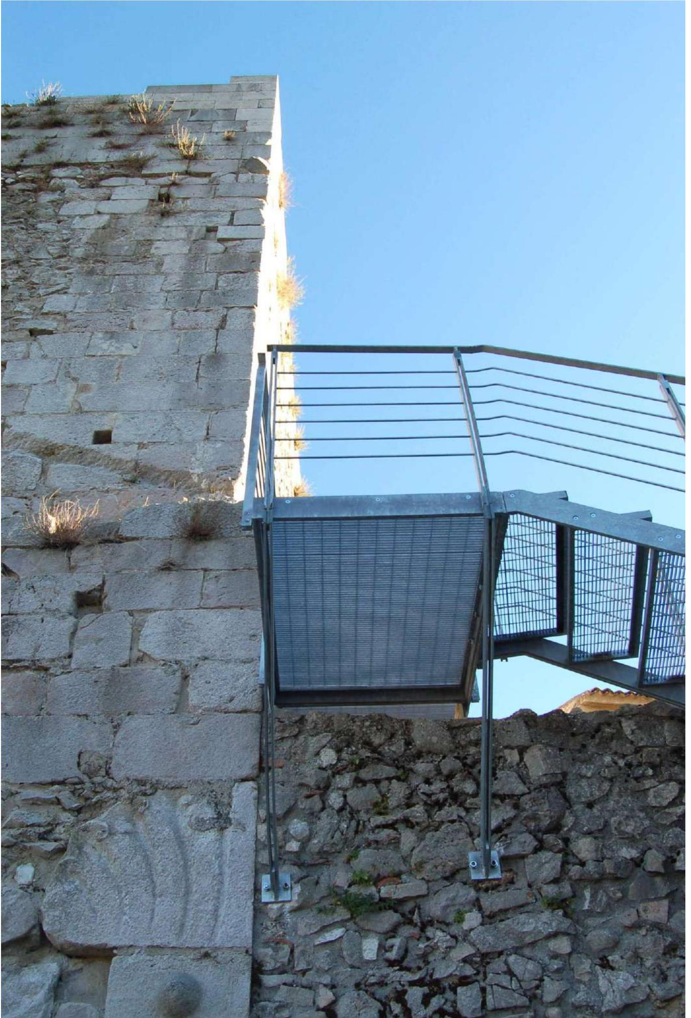
Scale e passerelle pedonali di visita, dettaglio struttura in acciaio zincato.
